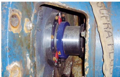
Une pompe de suspension est utilisée pour faire circuler le lait de chaux abrasif dans la centrale RWE de Frimmersdorf, en Allemagne; elle est équipée d'une garniture mécanique EagleBurgmann **HR325/270-G11-E6**. Conditions de service :  $p = 3 \text{ à } 4,5 \text{ bar}$ ;  $t = 50 \text{ °C}$ ;  $n = 890 \text{ min}^{-1}$ .
