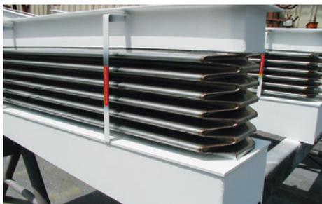
Des **compensateurs de dilatation** dotés de bords de forme spéciale sont installés dans un préchauffeur d'air dans la centrale d'East Kentucky, aux USA. Conditions de service :  $p = 0,07$  à  $0,24$  bar;  $t = 34$  à  $540$  °C.
