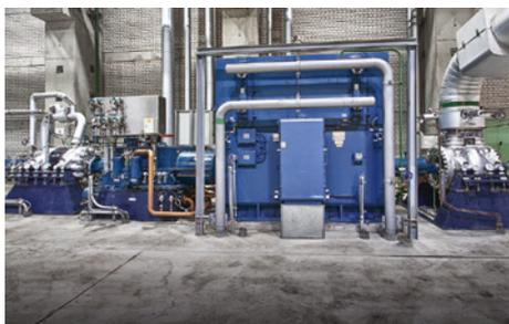
La centrale RWE de Niederaussem, en Allemagne, utilise une pompe Weller dans le circuit d'alimentation en eau. Une garniture mécanique de type **SAPV1/138-E2** est utilisée avec un système d'alimentation **SPF9025/A005-V1**. Conditions de service :  $p = 20,2 \text{ à } 27,5 \text{ bar}$ ;  $t = 177 \text{ °C à } 201 \text{ °C}$ ;  $n = 1000 \text{ à } 5100 \text{ min}^{-1}$ .
