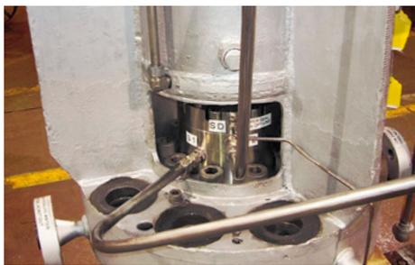
Une pompe de circulation de chaudière est installée dans le circuit d'alimentation en eau de la centrale municipale de San Antonio, au Texas. L'arbre de la pompe est muni de deux garnitures mécaniques **SHFV3/125-FTA**. Conditions de service :  $p = 170 \text{ bar}$ ;  $t = 340 \text{ °C}$ ;  $n = 1800 \text{ min}^{-1}$ .
