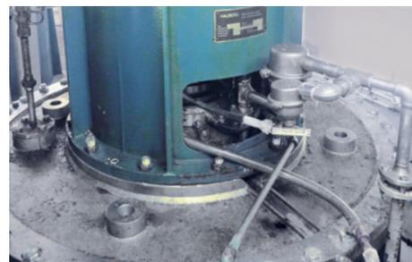
Des garnitures EagleBurgmann **HGH210/225-E1** sont installées dans la pompe d'eau de refroidissement principale de la station KNG de Rostock. Conditions de service :  $p = 2,25 \text{ bar}$ ;  $t = 25 \text{ °C}$ ;  $n = 490 \text{ min}^{-1}$ ; fluide : eau saumâtre contenant du sable.
