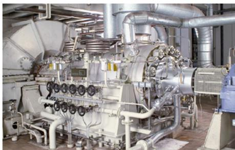
Une garniture mécanique **SHV1/200-E1** est installée dans une pompe d'alimentation en eau KSB CHTA140, dans la centrale ENBW de Heilbronn, en Allemagne. Conditions de service :  $p = 30 \text{ bar}$ ;  $t = 180 \text{ °C}$ ;  $n = 5100 \text{ min}^{-1}$ .
