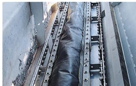
Des compensateurs de dilatation **Fluastal** (9 x 5 m) en tissu spécial sont installés dans une conduite de gaz de combustion, dans la centrale EGAT de Wang Noi, en Thaïlande. Conditions de service :  $p = 0,074$  bar;  $t = 580$  °C.
